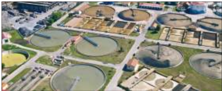
Fig. 14.1. Stație de epurare a apei
