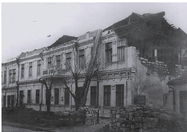
Fig. 20. Clădire din orașul Chișinău avariata de seismul din 10 noiembrie 1940
