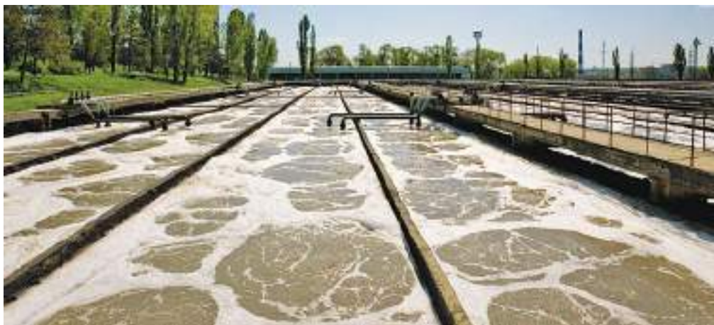
Fig. 101. Stația de epurare a apelor reziduale din municipiul Chișinău cu o capacitate de circa 6 600 m 3 /oră
