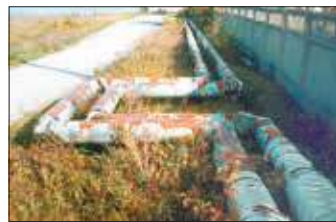
3.16. Buclă compensatoare a rețelei termice
